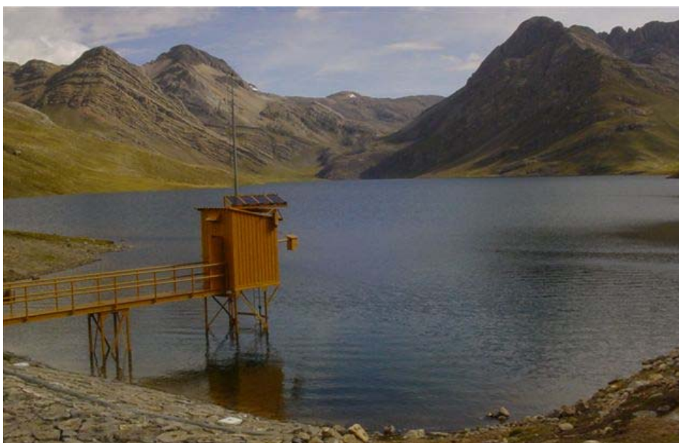
Figura 4. Vista de una EMC de la Laguna o Embalse de regulación
